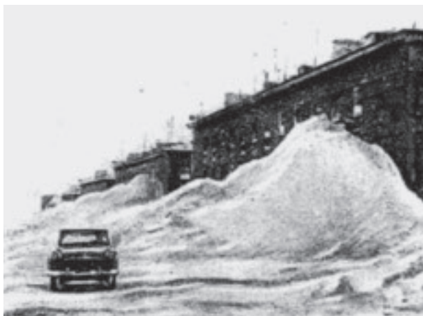
図-6 極圏の集合住宅にみられる吹きだまり 3)
