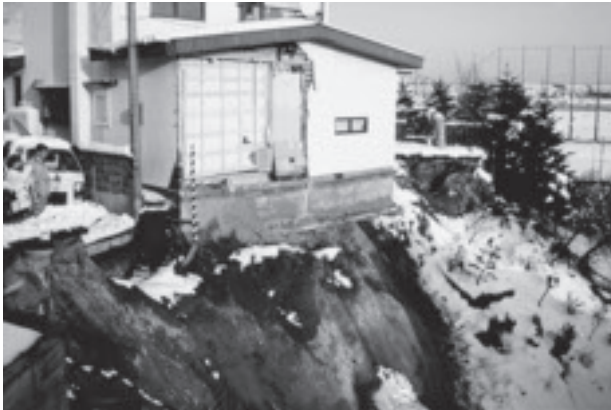
写真-5 半壊した住宅
