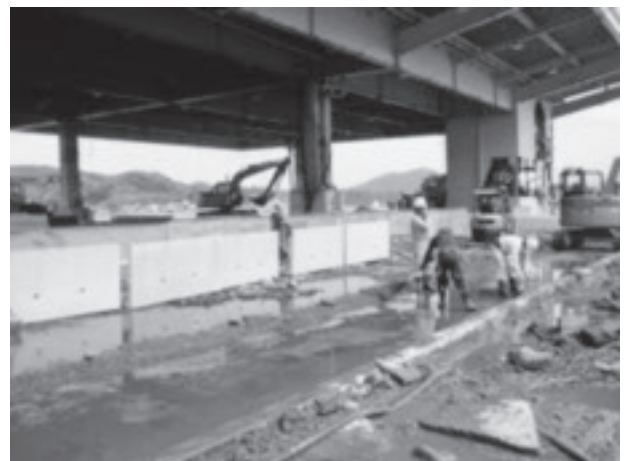
カツオ水揚げに向けた応急工事
