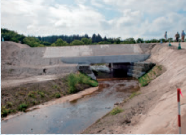
苫小牧川遊砂地工事の仮設切回し水路
