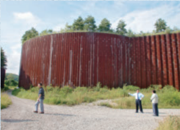
錦多峰川2号遊砂地の砂防堰堤
