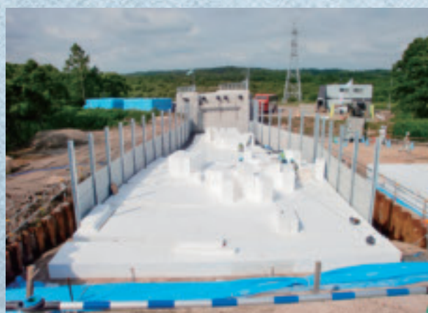
軽量盛土材(EPS工法)施工状況
