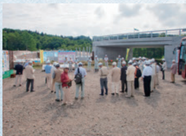
苫小牧川遊砂地の付替市道工事
