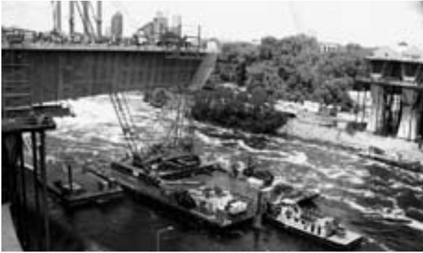
2007年に落橋したミネソタ-35 Wの復旧状況
