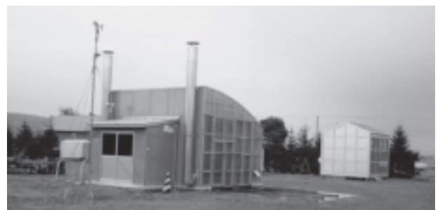
太陽熱を利用する環境配慮型の木材乾燥装置
