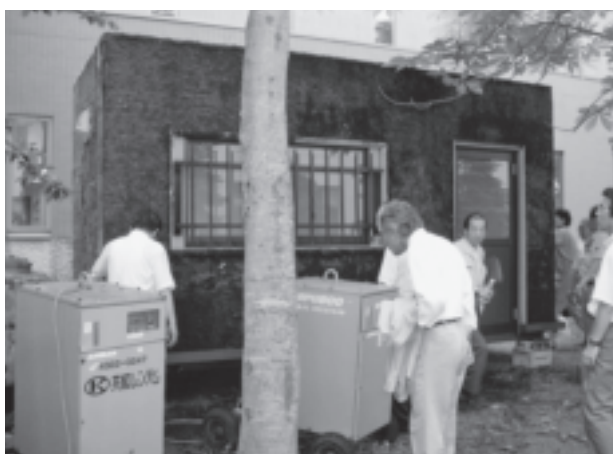
壁面に隙間無く繁茂したミズゴケ
