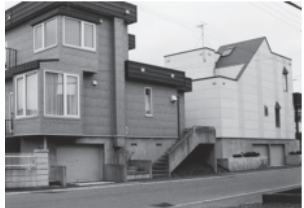
写真-2 総合治水対策前 耐浸水性住宅 (札幌市建築基準 H1.5 m)
