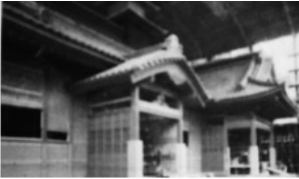
建物正面（西面）の内玄関と玄関の復元
