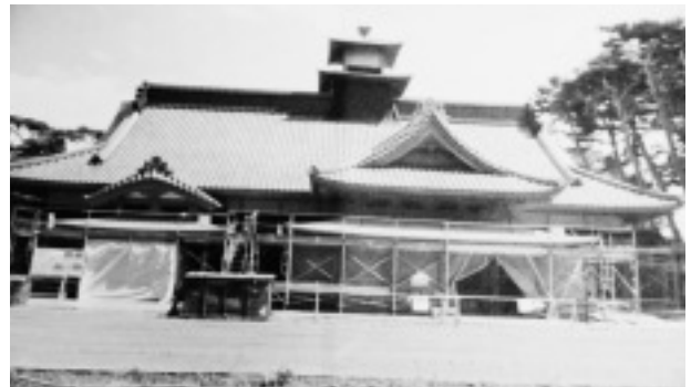
素屋根解体後の外観
