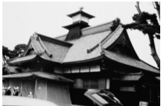
ほぼ完成の外観 玄関、南面
