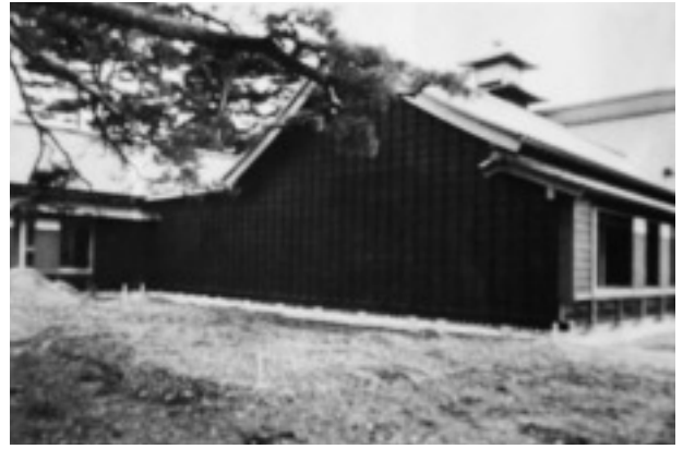
東面の外観（側面）
