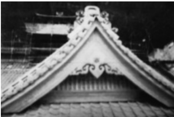
玄関式台の千鳥破風の三つ葉紋瓦の復元
