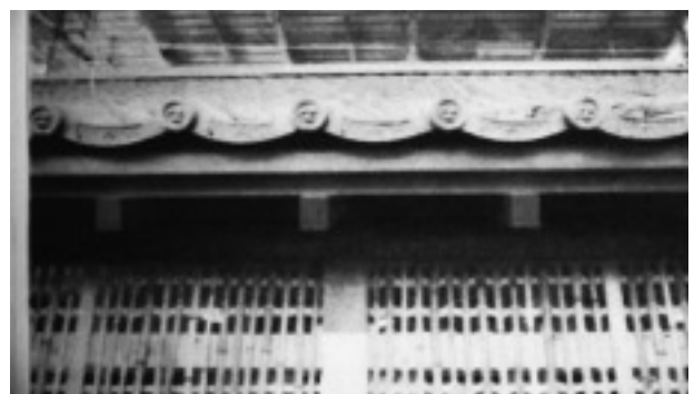
軒瓦と竹の小舞掻きの復元（外壁・竹、内壁・葺）
