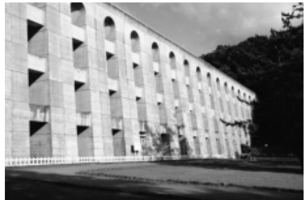
改修を終えた現在のダム
