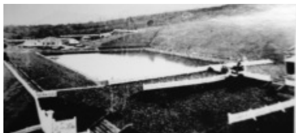
築造直後の低区配水池 明治21～22年
