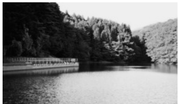
ダム貯水池 平成 21 年 10 月
