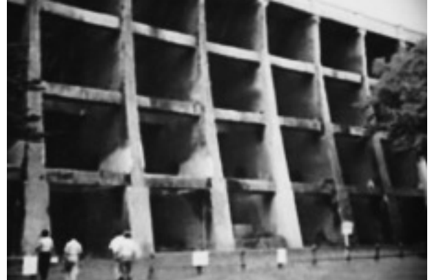
完成50年を経過した旧ダム
