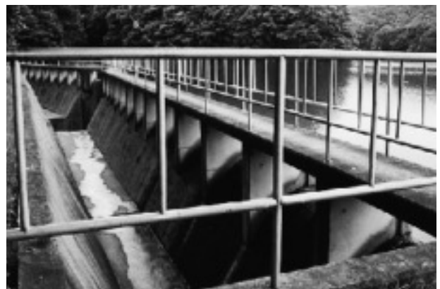
ダム洪水吐 (昭和 58~59 年で改修)
