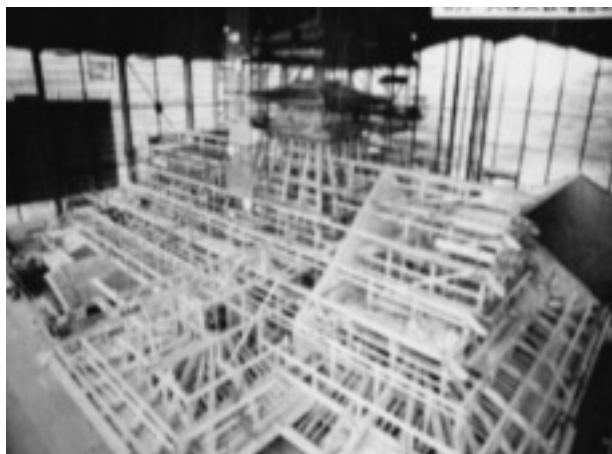
'8年8月大棟太鼓櫓施工中
