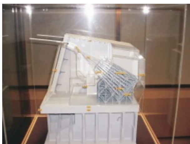
橋台内部の模型／白鳥大橋記念館
