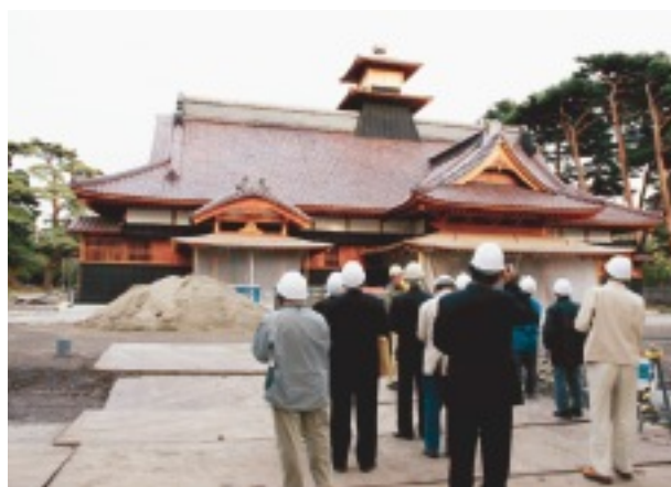
箱館奉行所復元工事（五稜郭公園）
