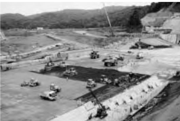
当別ダムは、ダムサイトに約 20 m の厚さで堆積している河床砂礫に水とセメントを加えて混合する「CSG 工法」を台形形状の「台形ダム」に適用する「台形 CSG ダム」という新しい形式のダムです。
