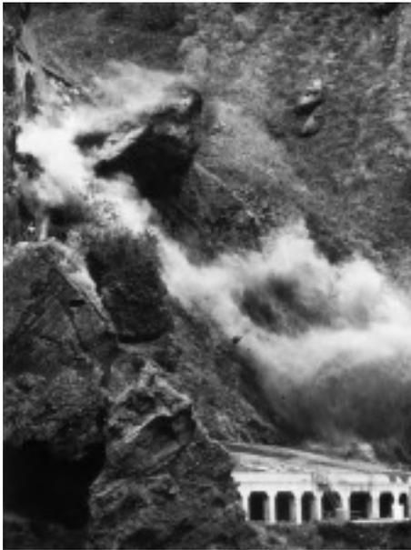
写真-4 巨大岩体の転倒発破
