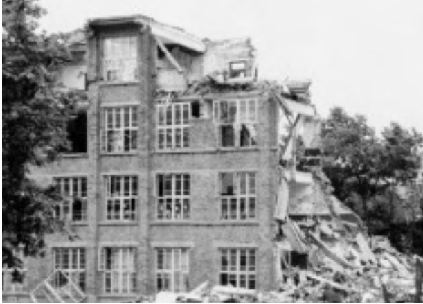
写真-4.11 学校の崩壊（重慶大学提供）
