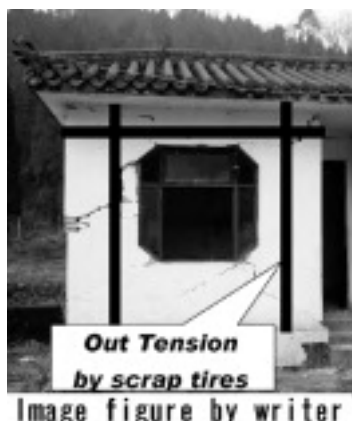
図-4.2 スクラップタイヤを利用した補強
