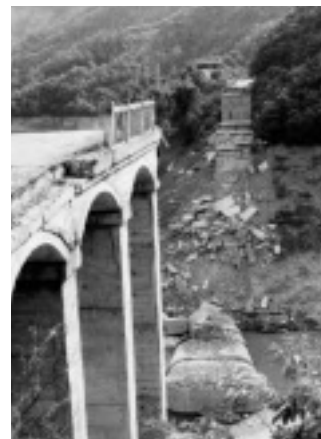
写真-4.16 井田提大橋の落橋（西南交通大学提供）
