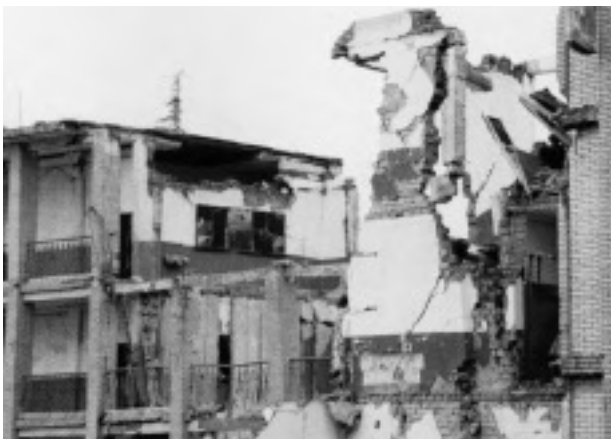
写真-4.13 学校の崩壊（重慶大学提供）
