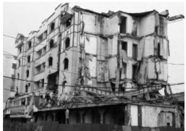
写真-4.8 都江壱市のビルの崩壊
