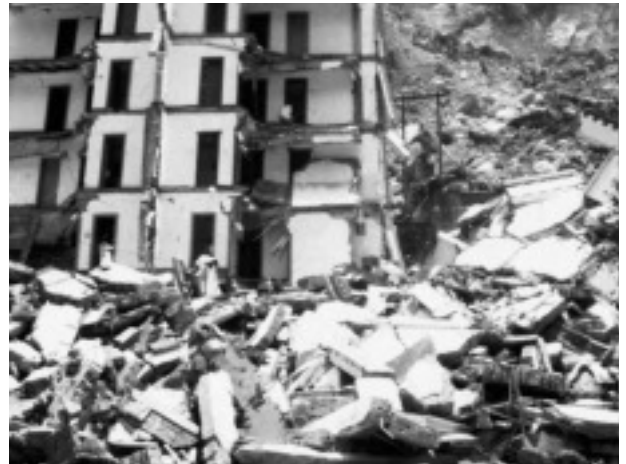
写真-4.21 北川縣市街崩壊（西南交通大学提供）
