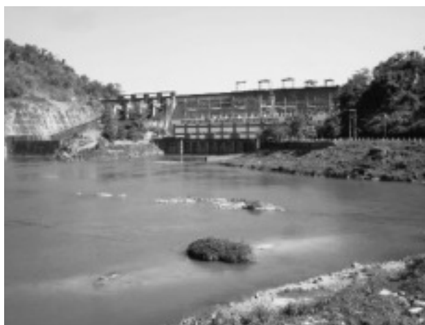
写真－2 ナムグムダム堤体
