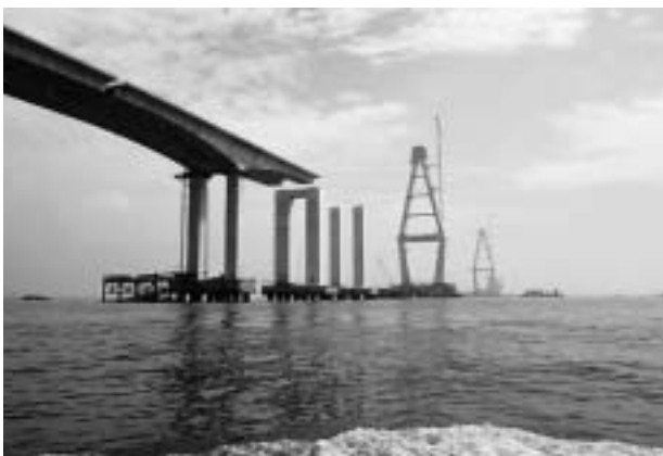
建設中の仁川大橋（長840m、高70m）
