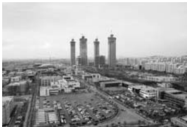
超高層住宅の建設
