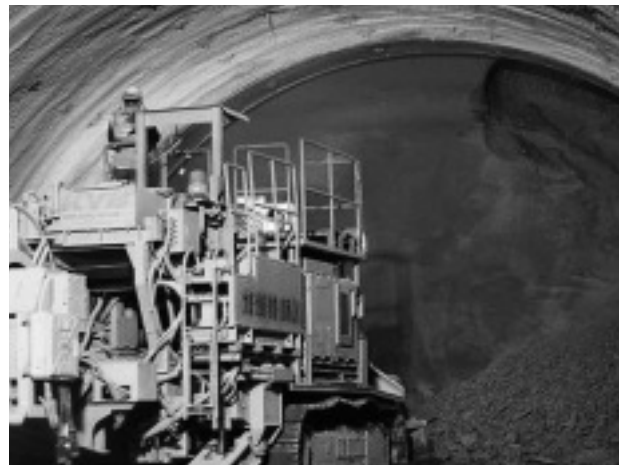
図－1 西側工区トンネル切刃
