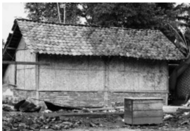
復旧された民家
