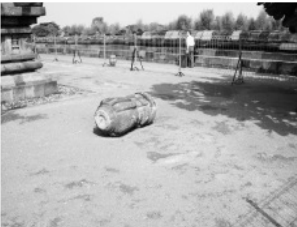
倒壊した主塔の一部
