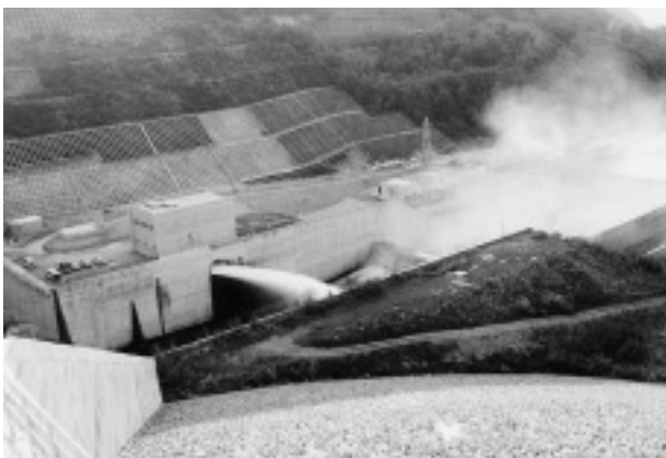
忠別ダムの放流状況
