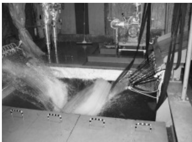
写真-6 氷蓄熱水槽への投入状況
