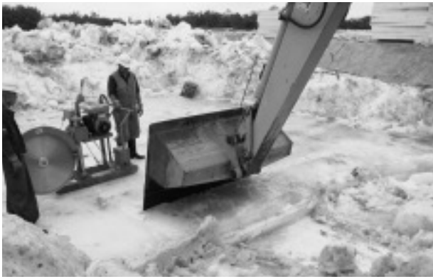
写真-3 専用切出し機とバックホウによる氷切断状況
