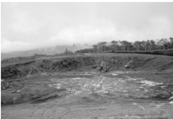
工事中の上部調整池
