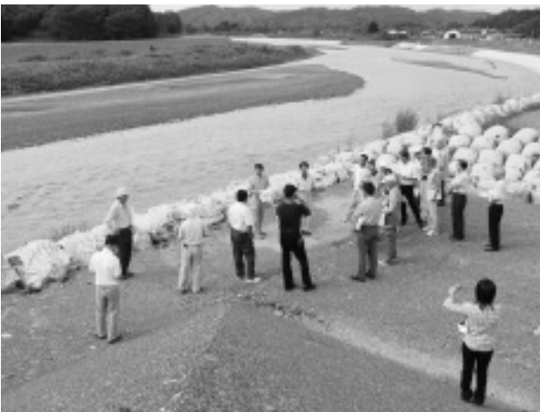
厚別川の災害復旧現場
