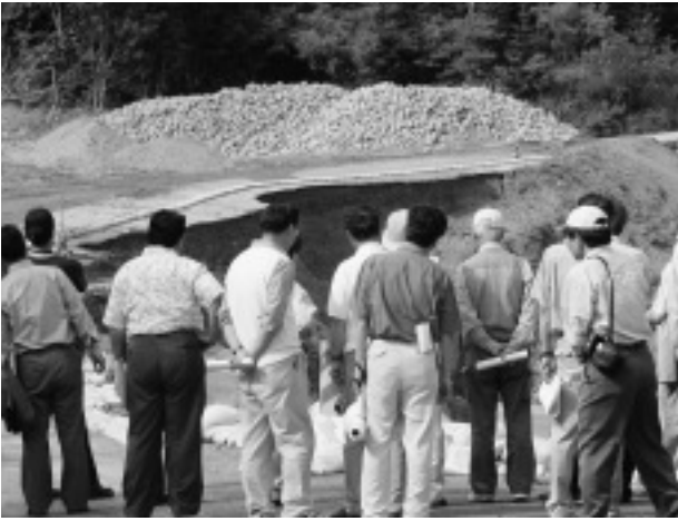
土砂崩れによる被災箇所の復旧工事を見学
