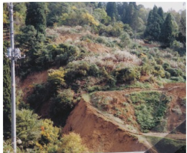
山間部の地滑り崩壊箇所
