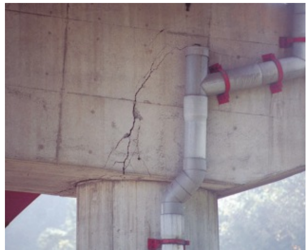
山辺橋 ラーメン橋脚の塑性ヒンジ
