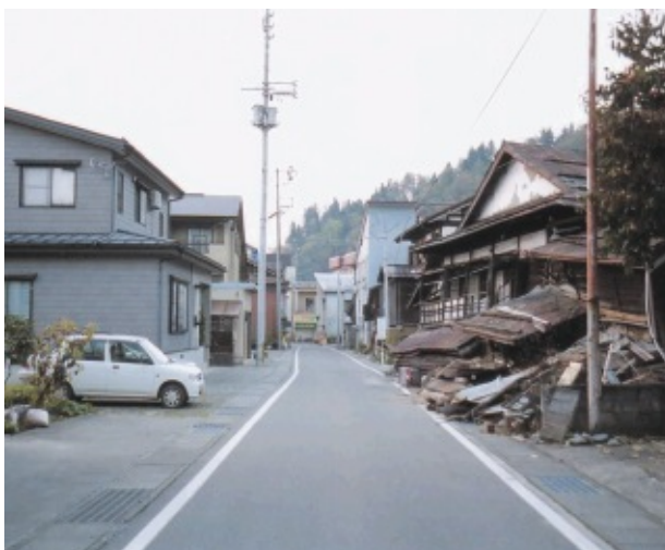
川口町 新旧住宅形式による被害の差異
