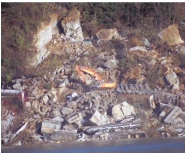
長岡市妙見地区 岩盤崩落による事故現場
