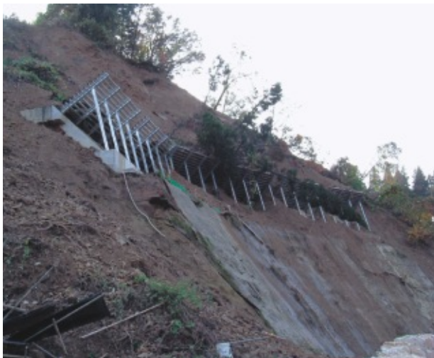
小千谷市 斜面崩落雪崩防止柵効果
