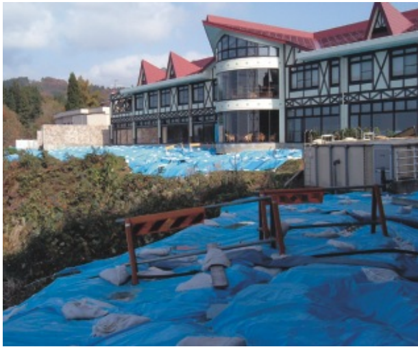
川口町 ホテル蒼丘裏地の斜面崩落
