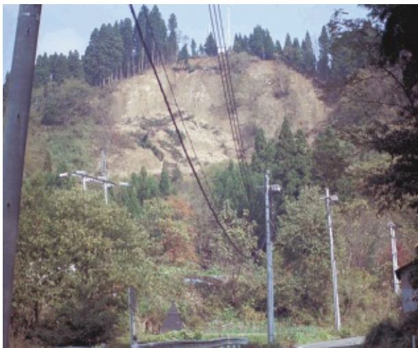
川口駅背面の地滑り箇所
