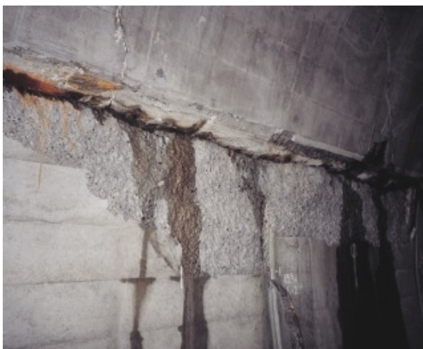
県道荒谷トンネル SPL 付近の段差的崩壊
