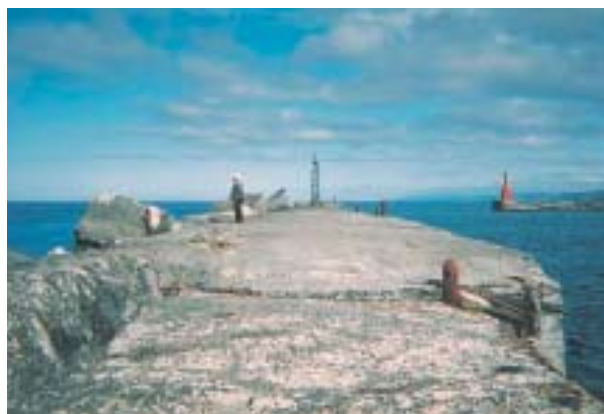
ホルムスク港の防波堤 戦前、日本が建設した防波堤をそのまま利用している 右上は係船柱 [96号 2002.1]
