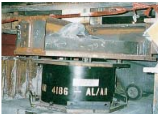
サンフランシスコ市庁舎で設置中の免震支承。590個のゴム支承を 使い、M8.3の地震にも耐える構造が完成する。
