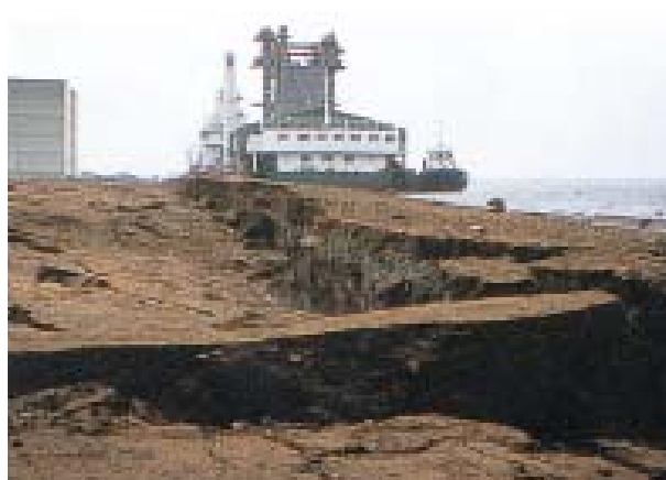
液状化による埋立地の被害
