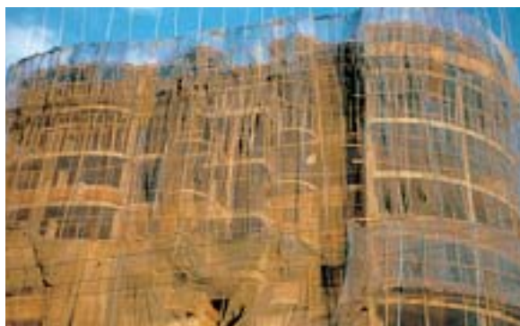
ヤンゴン市内の建築工事現場。足組みは竹製、竹がたわんで少し怖い。柱、梁の寸法は小さく、大丈夫だろうか？ コンクリートは現場打ち。 [87号 1992.2]
