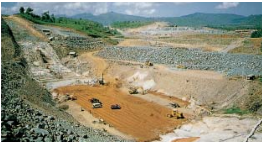
円借款によるダム工事現場（インドネシア）[84号 1998.2]
