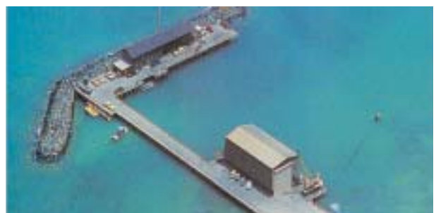
水施設設計コンサルタント マカイ・オーシャン・エンジニアリングの社屋 [90号 2000.2]
