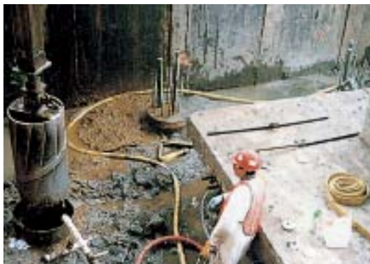
柱の補強により不足する基礎の体力を補うため、増し杭とフーチン グの拡大を行っている。
