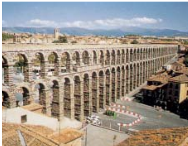
スペインのセゴビア にあるローマ時代の モニュメント石造り 水道橋。 全長728m、高さ 28m。アーチの数は 167を数える。 10数年前まで、セ ゴビア市民に水を提 供していたという。 御影石だけを組み合 せて、2000年も崩 壊することないロー マ人の英知を物語る ものである。 [69号 1993.6]
