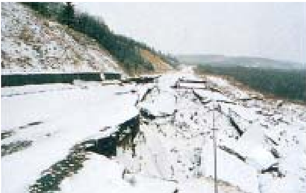
国道44号、厚岸町糸魚沢 片切片盛した地点の崩壊で崩壊延長は約 70m盛土された地盤は泥炭地盤である。
