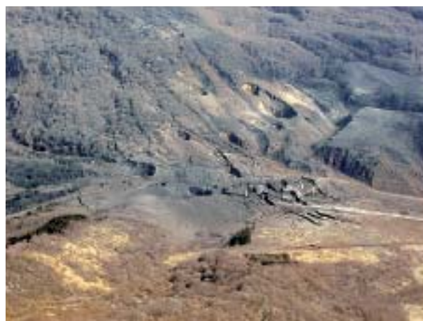
西山山麓にできた亀裂（平成12年4月7日撮影）
