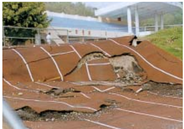
台中県霧峰郷光復国民小学校に隣接する陸上競技場、震央の北北西約25km。 断層は競技場を斜めに横切り、トラック面に数mの段差を発生させた。 フェンス背後のトラックでは少年野球チームが練習を行っていた。
