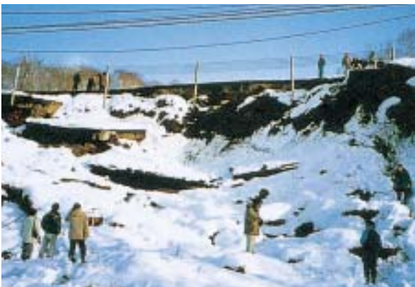
国道44号、厚岸町糸魚沢 片切片盛した地点の崩壊で崩壊延長は約 70m盛土された地盤は泥炭地盤である。
