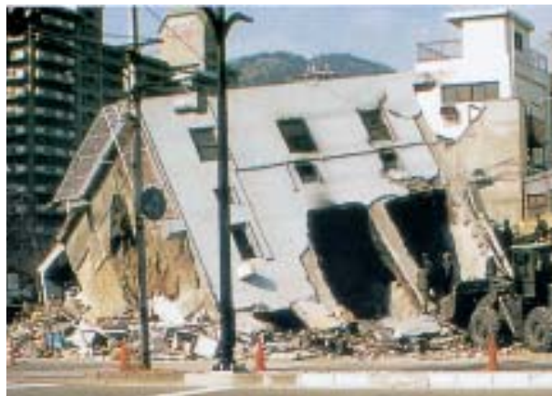
神戸市三宮地区 4階建ビルの崩壊
