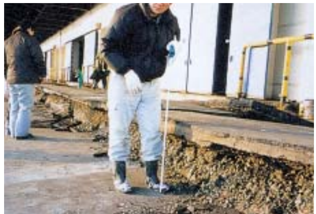
緑が岡6丁目の斜面崩壊 火山灰質土からなる斜面が幅70m、長さ 20m、高さ11mにわたって崩壊した。
