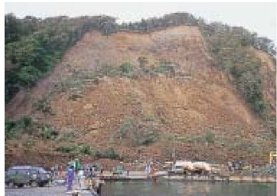
大規模な斜面崩壊（奥尻港背後斜面）
