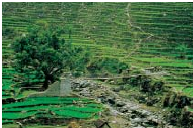
山の中の吊り床板歩道橋。段差を取る為の石造りの橋台が緑の段々畑の景色と調和している。段々畑を維持する為の水路の技術には驚かされる。[70号 1993.6]
