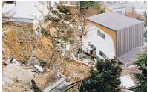
緑が岡6丁目の斜面崩壊 火山灰質土からなる斜面が幅70m、長さ 20m、高さ11mにわたって崩壊した。
