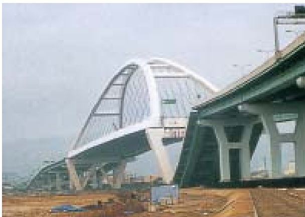
阪神高速5号湾岸線 西宮港大橋アプローチ橋の落橋
