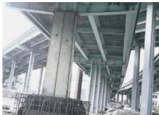
サンフランシスコ市内の古いフリーウェイの耐震補強工事。鋼板で 柱を補強し、さらに基部はリブでフーチングに固定する。
