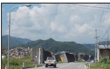
大槌町被災防潮堤 H25.8
