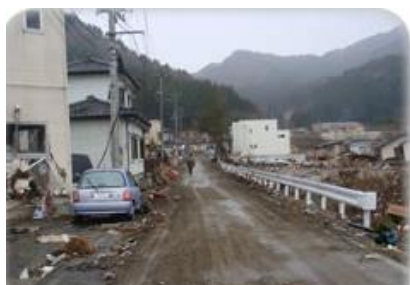
鶴住居小学校の生徒らが避難した道路 (群馬大・災害社会工学研究室提供)
