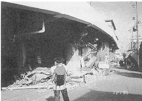
写真-10 阪神電鉄鉄道高架の崩壊
