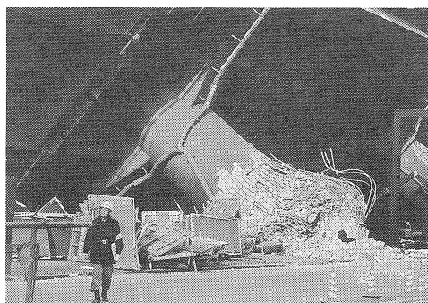
写真-2 阪神高速3号神戸線 ピルツ橋の倒壊
