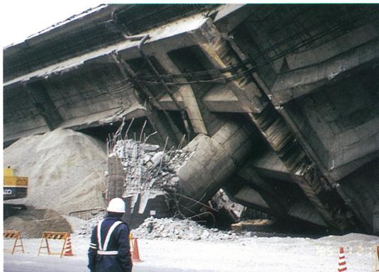
ピルツ橋脚のセン断破壊か？
