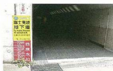
危険水位を示した地下道
