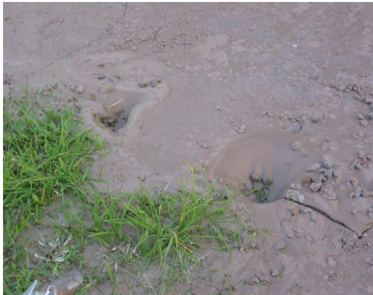
写真－1 札幌市清田区の住宅街で発生した液状化跡 （独立行政法人寒地土木研究所 HP より転載）
