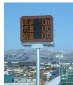
写真-5.1 道路情報板・気象情報板
