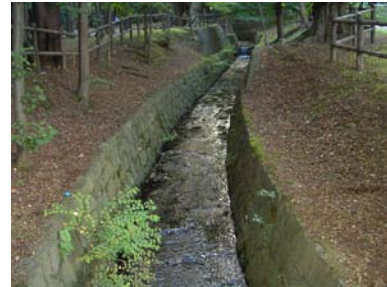
写真－2 円山公園内水路
