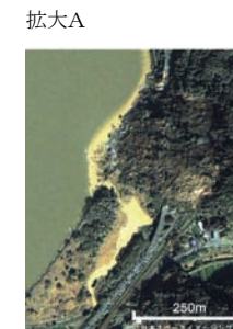
拡大図A 長岡市神尾町・黒島小千谷長岡線が地すべりで不通
