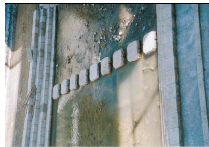
堰柱と堰板（神戸市内住吉川） 石の間に板を差し込み堰上げる
