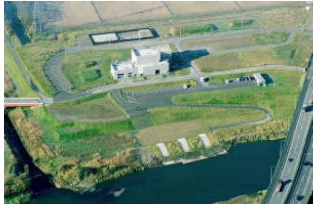
写真-2 北広島地区河川防災ステーション 2)
