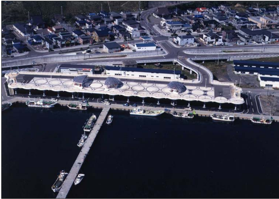
写真－１ 人工地盤(北海道奥尻町・青苗漁港)
