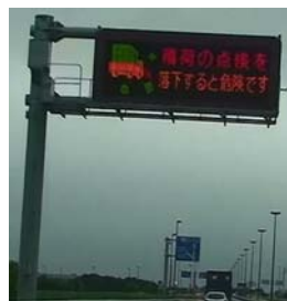
写真-5.1 道路情報板・気象情報板
