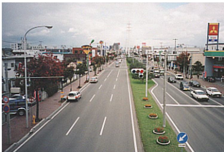
写真-1.2 全6車線で供用中の環状通り一般部
