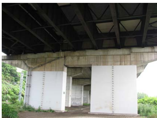
写真-2.1 阪神後の橋脚補強(室蘭新道)
