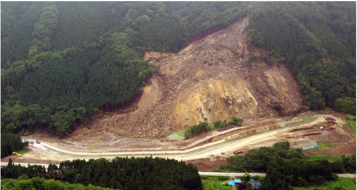
写真-3 平成20年岩手・宮城内陸地震における斜面崩壊と河道閉塞
