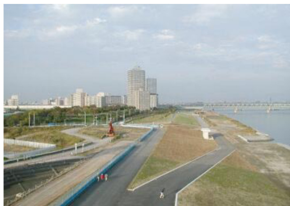
写真-1 高規格堤防と緊急河川敷道路 (荒川下流 小松川地区) 1)
