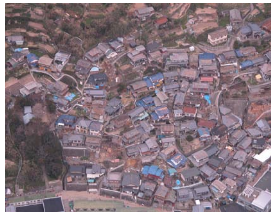
写真-8 福岡県西方沖地震による地盤崩壊状況
