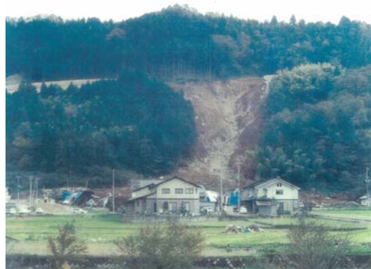
写真-5 台風23号による土砂災害の状況
