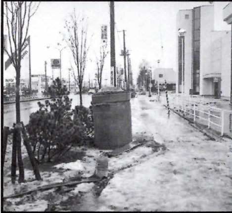
北海道釧路市内・液状化によるマンホール 浮上がり
