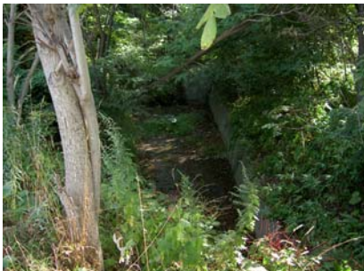
写真 6 : 山麓道路の上流側
