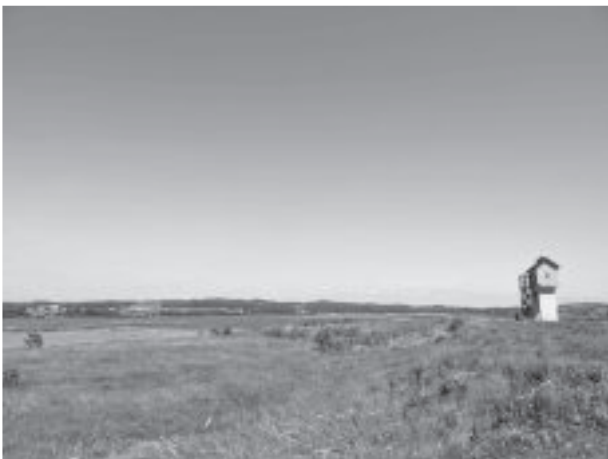
写真-10 舞鶴排水樋門
