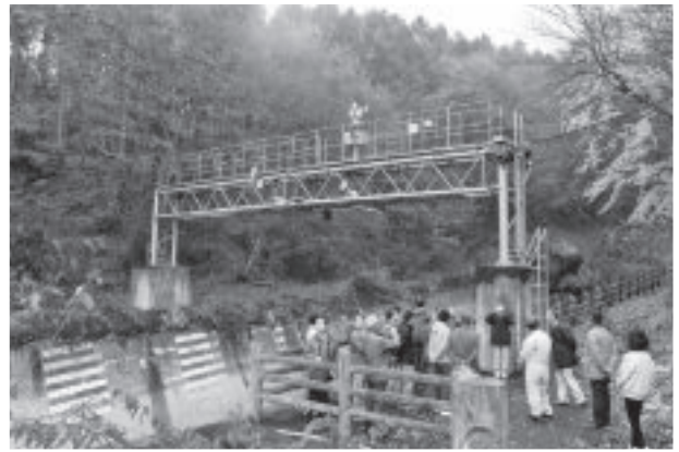
写真-6 現地視察状況(岩桶観測所)
