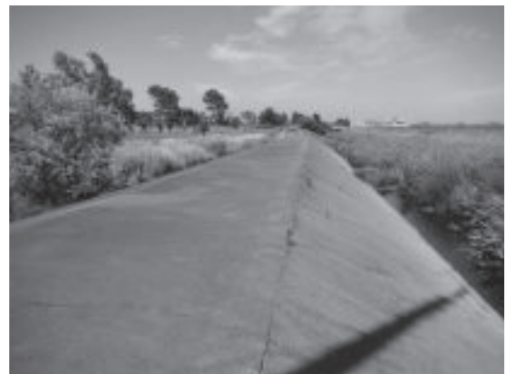
写真-2 伏籠川遊水池の越流堤
