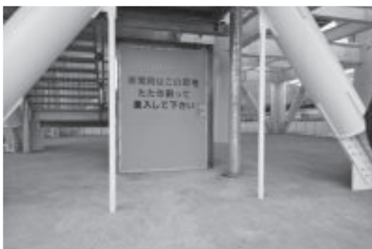
写真-31 階段への進入口
