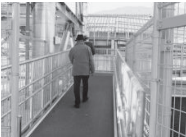
写真-4 スロープによる避難
