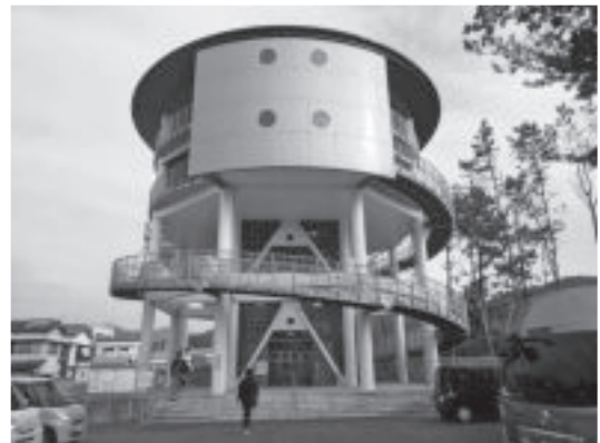
写真-19 第1号津波避難タワー(純平タワー)全景
