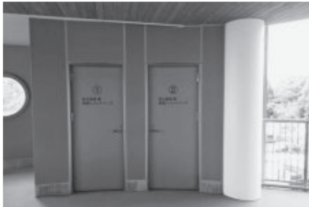
写真-23 防災倉庫兼簡易トイレスペース
