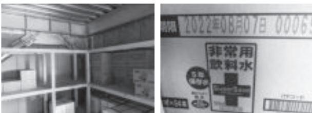
写真-6 緊急物資収納庫の内部(2F)
