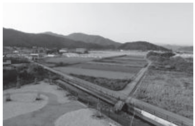
写真-15 周辺からの津波避難タワーへのアクセス
