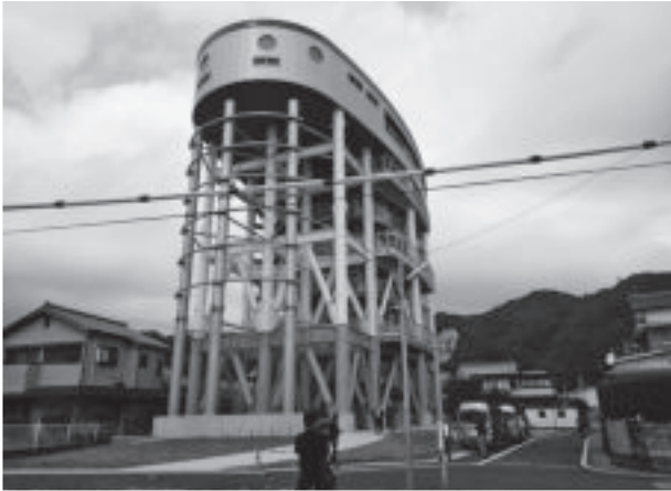
写真-26 佐賀地区津波避難タワー全景
