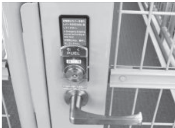
写真-2 常時は立入禁止(施錠)
