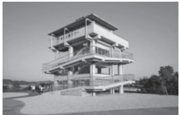
写真-14 甫湊公園津波避難タワー全景
