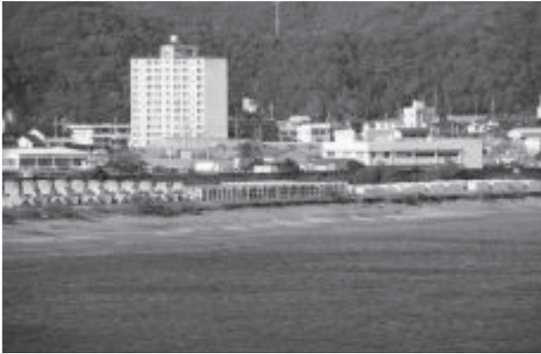
写真-3 第2ライン津波防波堤の現況
