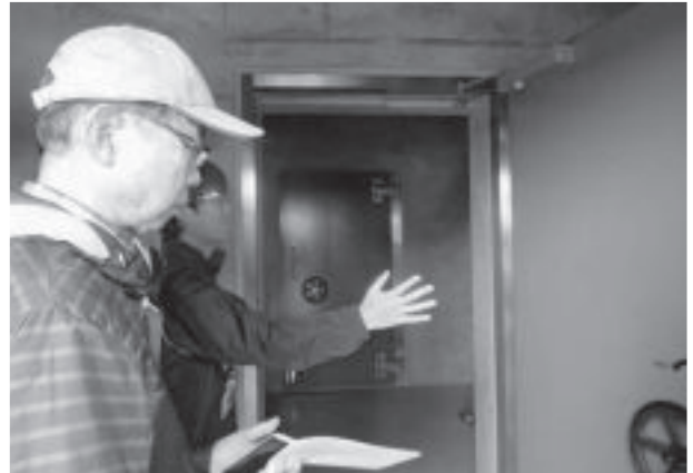
写真-8 津波シェルターの二重止水扉
