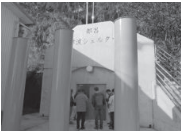
写真-7 津波シェルター衝突防止杭
