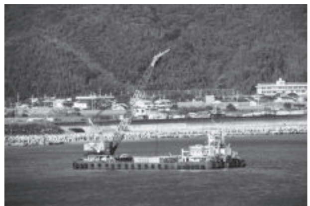
写真-2 第1ライン防波堤延長工事(直轄)
