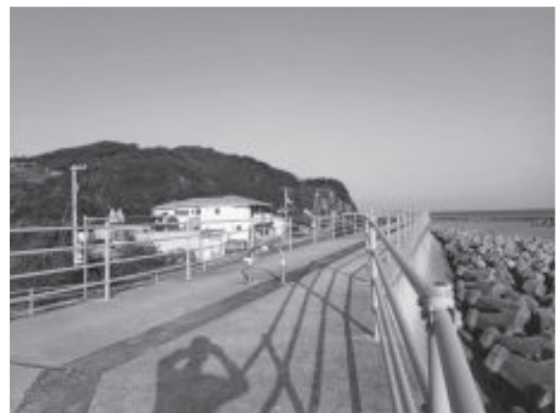
写真-5 高知市春野地区の海岸堤防・海岸側
