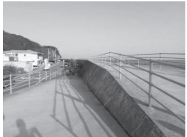
写真-4 高知市春野地区の海岸堤防・人家側
