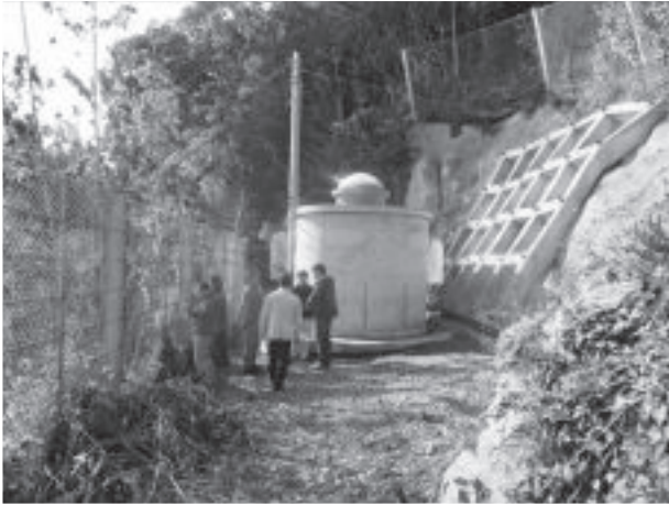
写真-17 立坑・螺旋階段から屋外へ
