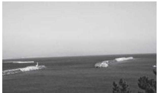
写真-1 「第1ライン防波堤」の現況
