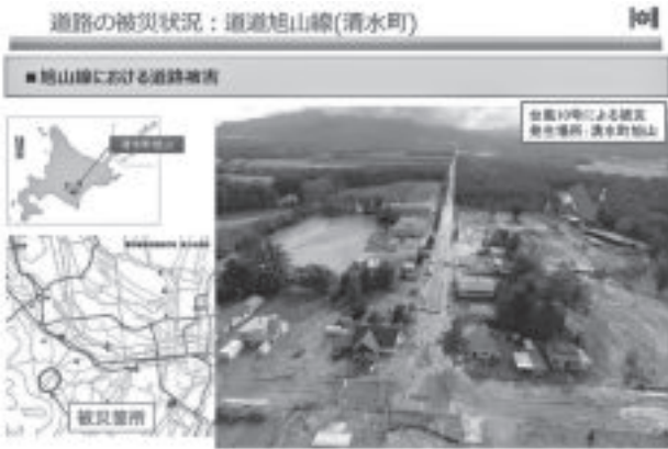
図-18 道路の被災状況(道道旭山線)
