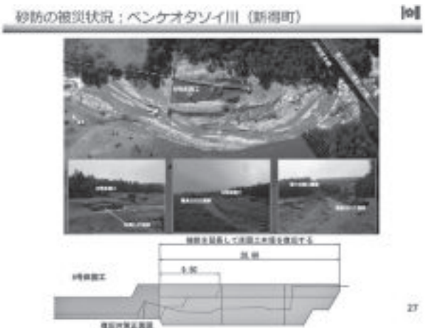
図-17 砂防の被災状況(ペンケオタソイ川)
