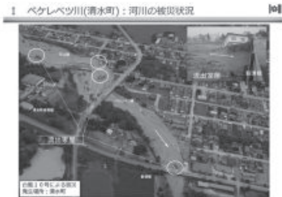
図-19 ペケレベツ川の被災状況
