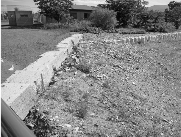
写真-2 再利用されているコンクリートブロック
