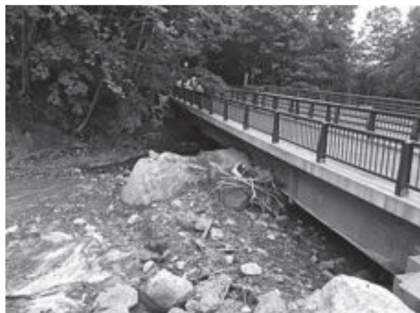
写真-8 湖水橋の状況(桁下の石は直後に撤去)
