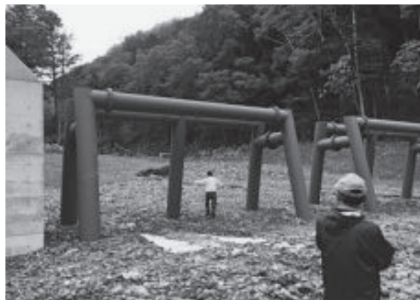
写真-7 新設された治山ダム(谷止工)
