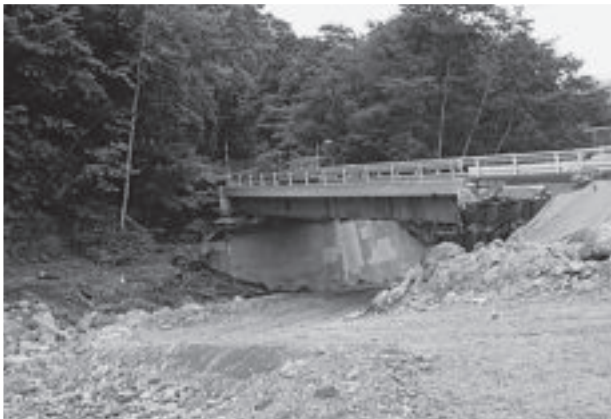
写真-5 丸駒橋の状況
