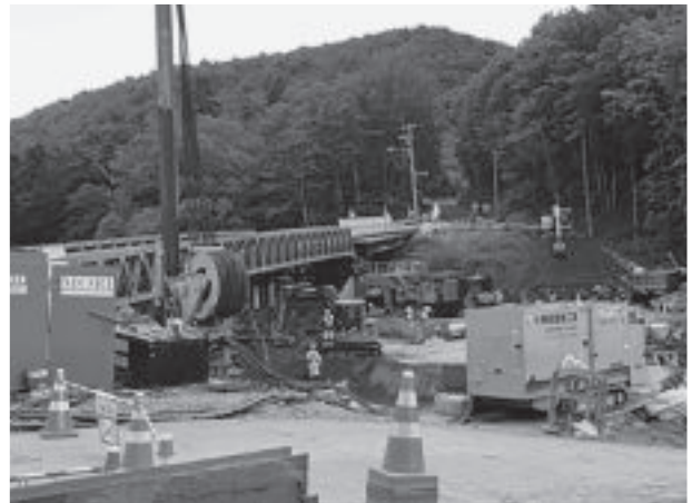
写真-3 「奥漁川橋の復旧作業状況」
