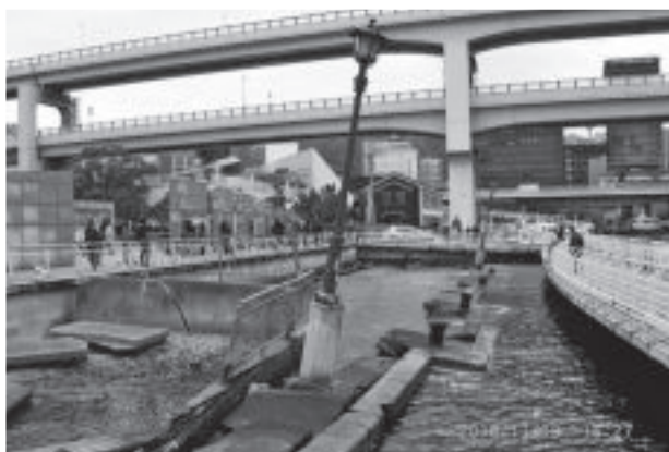
写真-3 メリケン波止場の遺構
