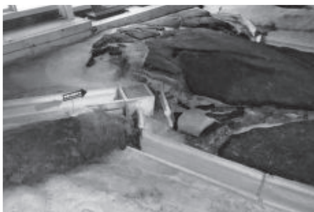
写真-2 野島断層保存館内のズレが生じた側溝 (執筆：水工部会 渋谷 義仁)
