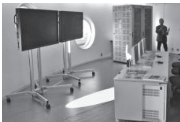
写真-4 自動開閉遠隔操作制御システム (執筆：都市部会 藤田 和成)
