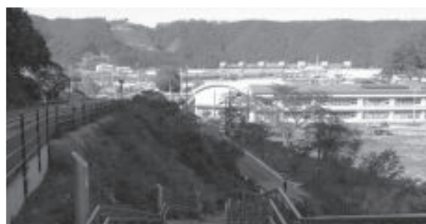
写真-1 小本小学校の新たな津波避難階段
