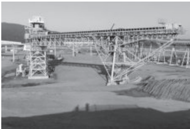
写真-7 仮置きヤードの巡回ベルトコン
