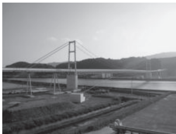
写真-5 気仙川渡河部のベルコン用吊橋
