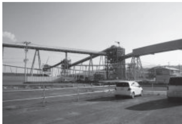
写真-4 市街地に設置されたベルトコンベア
