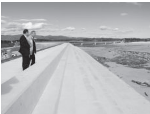
写真-2 夏井地区海岸CSG堤(海側)
