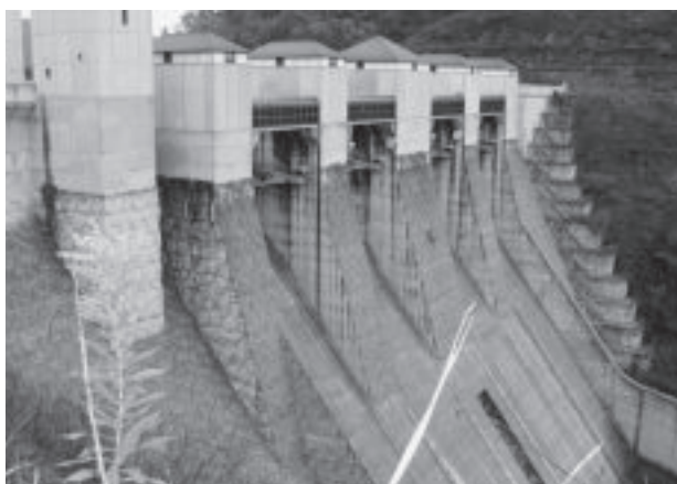
写真-3 三春ダム 堤体(化粧型枠使用)
