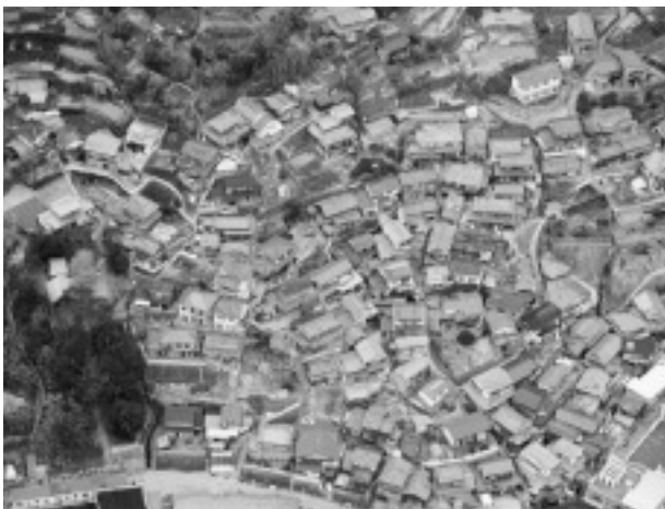
写真6 福岡県西方沖地震による玄海島の地盤崩壊状況
