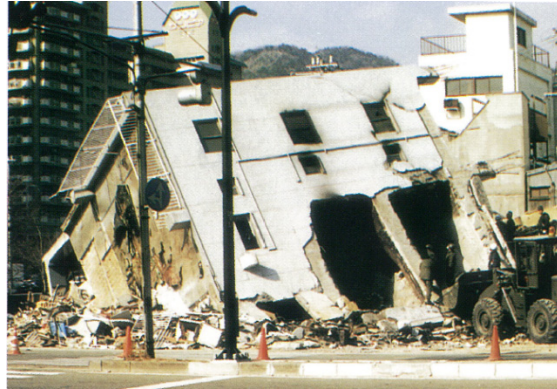
神戸市三宮地区 4 階建てビルの倒壊
