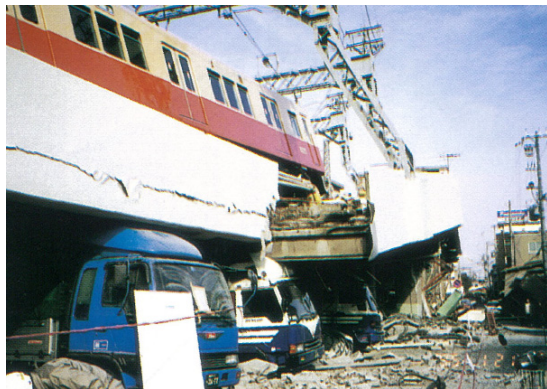
阪神電鉄 鉄道高架橋の破壊
