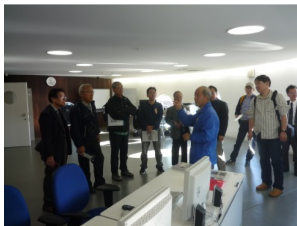
福良港津波防災ステーション 制御室で説明を受ける
