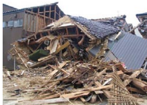
平成19年新潟県中越沖地震で 倒壊した家屋
