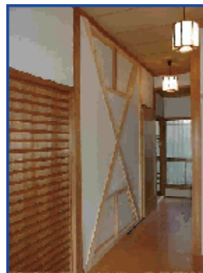
筋かいによる補強
