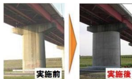
橋脚の補強例
