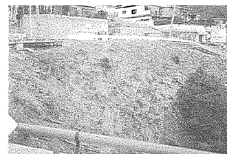
のり面格工の破壊 により路面にクラック発生（シートで保護） 【神戸市東灘区】
