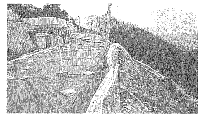
のり面格工の破壊 により路面にクラック発生（シートで保護） 【神戸市東灘区】
