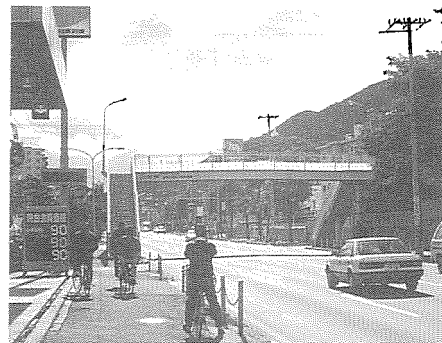
〔南 9 西 22〕 歩道の通行を妨げる歩道橋
