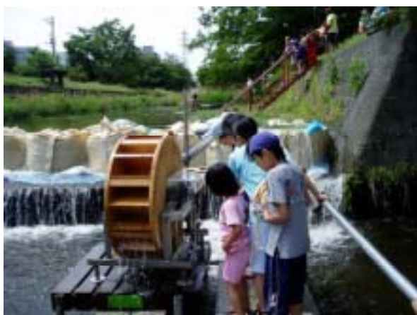
[水車発電の状況]
