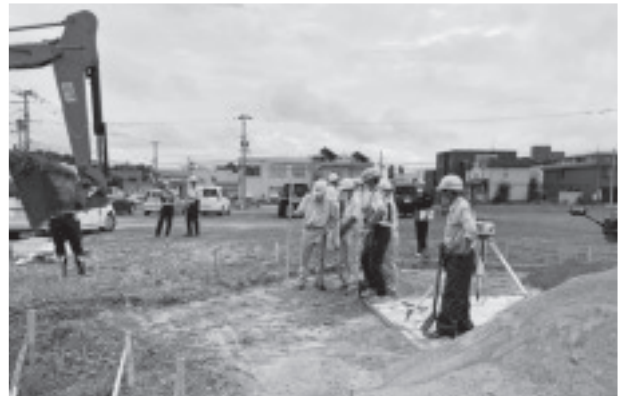
回転レーザーレベルを使用した掘削作業
