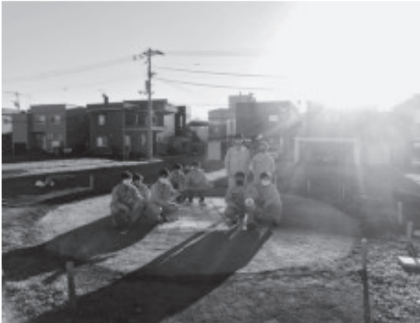
カラー舗装完了後の記念撮影
