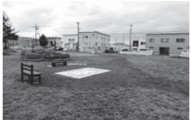
ダスト舗装の完了
