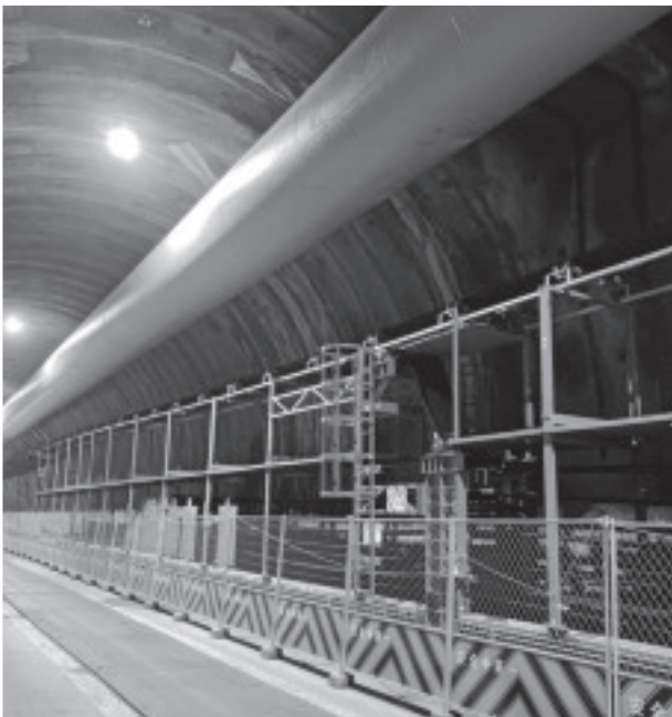
写真-3 ずり出し用のベルトコンベア
