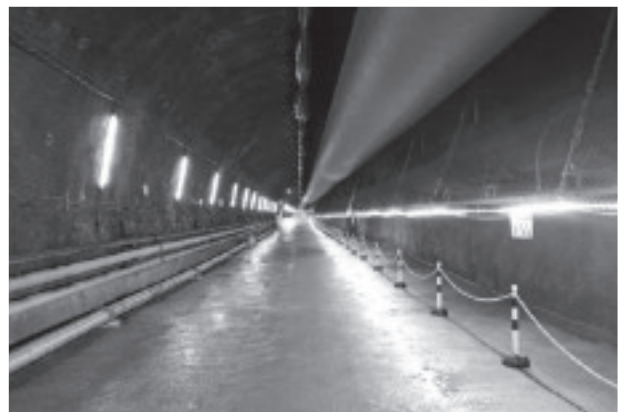
写真-1 トンネル内全景(斜坑)
