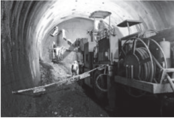
写真-2 支保工建込の様子(本坑)
