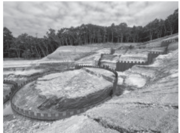
写真-3 熊の沢3号砂防堰堤下部工施工現場
